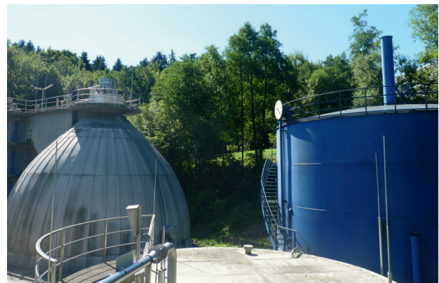
Energiespeicher – Faulturm und Gasspeicher der Kläranlage Radevormwald.
